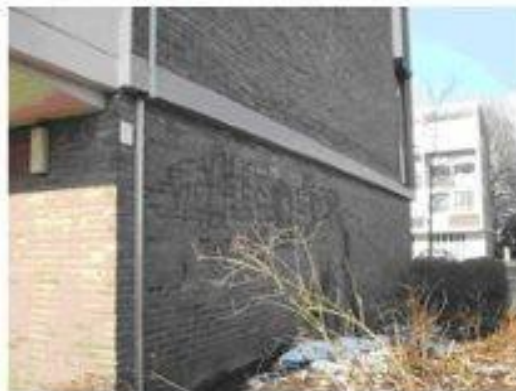
Foto E: braakliggende tuin, met graffiti op een muur
